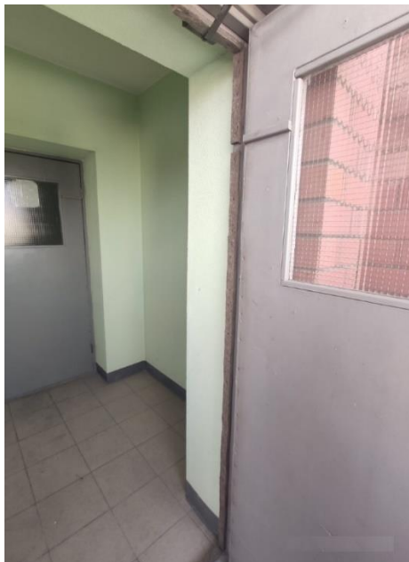
Деревянная отремонтированная и утепленная Дверь
