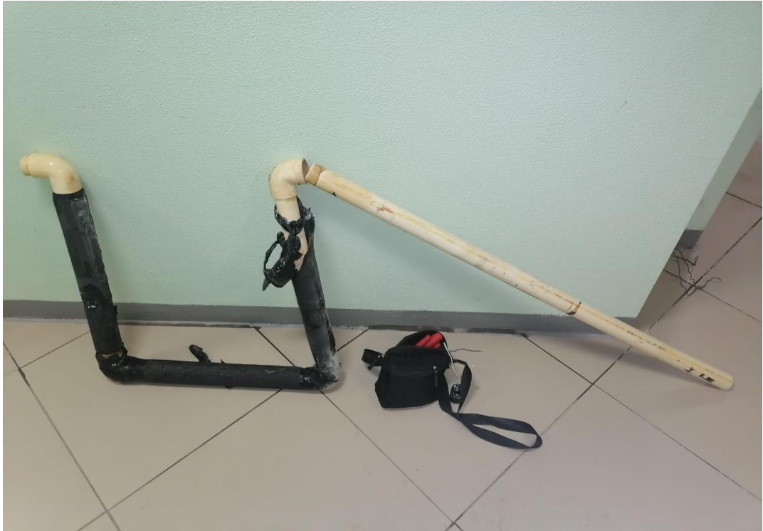
Пример разрушения ХПВХ трубопровода
